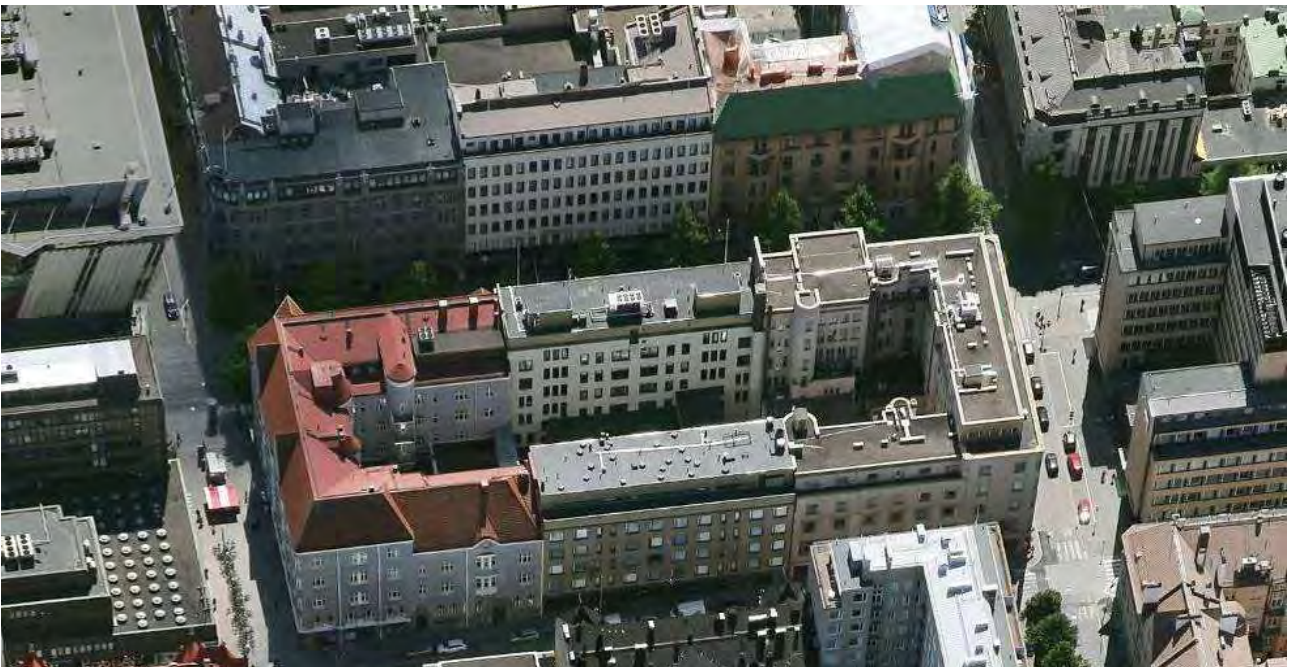
Alla: Viistokuva pohjoisesta. Takana vasemmalla Otrantalo, keskellä Turvantalo, oikealla Kymmenenmiehentalo. Kuvassa keskellä Yhdyspankintalo ja saman korttelin Kauppakadun varren asuintalo. (Bing.com, 2017 Blom)
